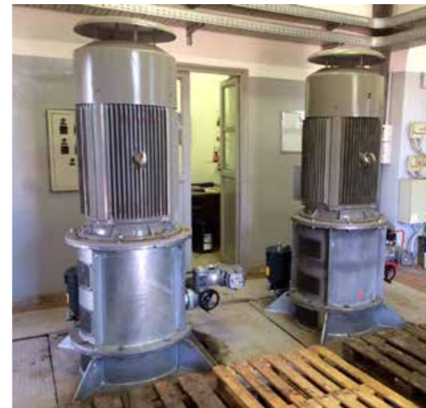
A sinistra: la cartina indica la località Buoro, dove troverà posizionamento il nuovo impianto idrovora. Qui in alto: due pompe idrovore
