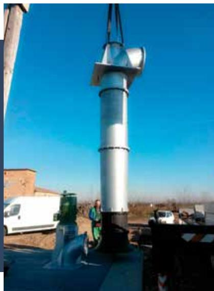
L'idrovora, "Pascoletti" al Prejon di Anguillara, dotata di elettropompe automatizzate, che permetterà l'espulsione di circa 216.000 metri cubi al giorno: il doppio della capacità precedente
