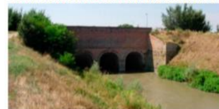
Il punto debole dell'intera asta fluviale del Fratta Gorzone è rappresentato dalla strozzatura della botte a sifone denominata "Tre Canne", ossia lo storico intervento fatto dai veneziani, alla metà del '500 per scolare le acque dell'imponete lago di Vighizolo, per far passare le acque del fiume Fratta sotto al letto del Santa Caterina-Frassine. Tale imbuto impedisce il funzionamento a pieno regime delle 11 idrovore poste a monte della Botte, basti pensare che a gennaio/febbraio 2014, l'Arpav ha misurato una portata in transito all'altezza di Valli Mocenighe inferiore a 60 mc/sec, pur con livelli idrometrici del Fiume oltre i limiti di guardia.
