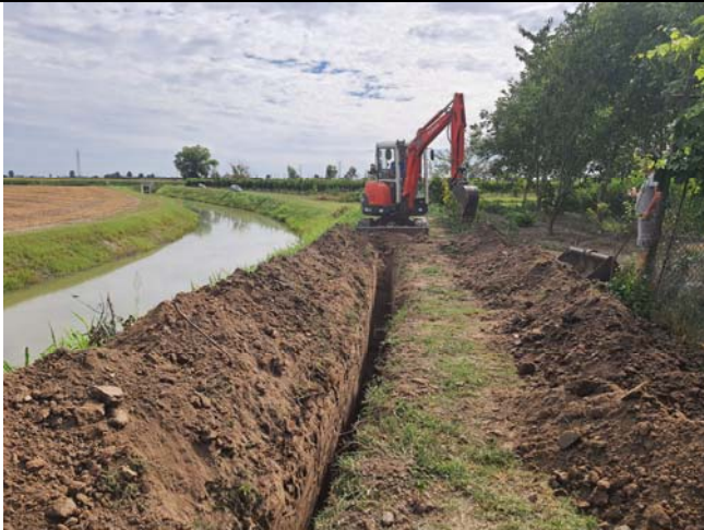
Scolo cons. Gallo in Comune di Bagnoli di S. Fase di scavo per posa di cavidotto di alimentazione elettrica del sostegno "Gallo".
