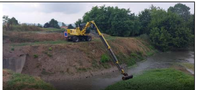
Canale Altipiano in Comune di Cartura. Esecuzione presidio di sponda costituito da pali infissi al piede spondale e pietrame, copertura con terreno per favorire l'inerbimento.
