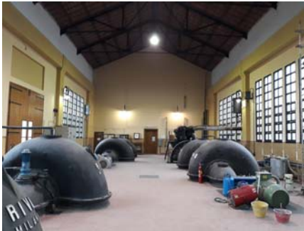
Idrovora Ca' Bianca di Chioggia – Lavori in D.A. di sistemazione interna degli intonaci e tinteggiatura
