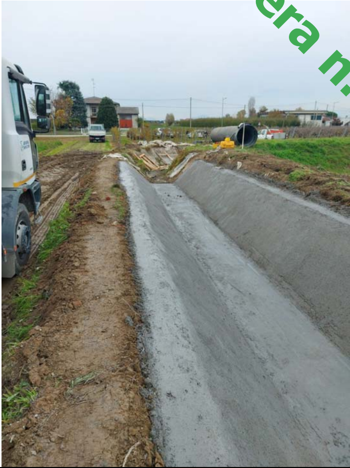
Espurgo scolo Marana Bassi ad Anguillara veneta (PD)
