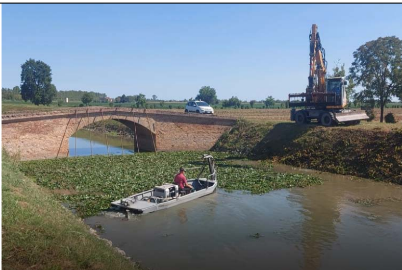
Canale Altipiano in Comune di Correzzola. Attività di sfilcio con motobarca diserbatrice.
