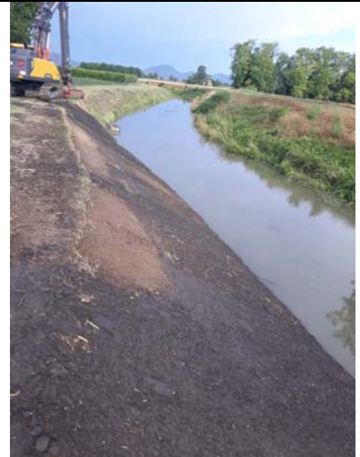
Canale Altipiano in Comune di Cartura. Esecuzione presidio di sponda costituito da pali infissi al piede spondale e pietrame, copertura con terreno per favorire l'inerbimento.
