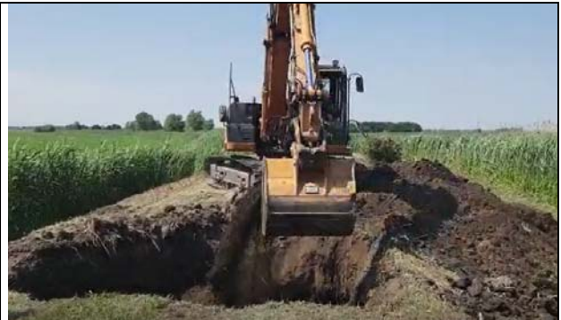
Canale dei Cuori in Comune di Cavarzere. Tamponamento e messa in sicurezza di un'infiltrazione arginale.
