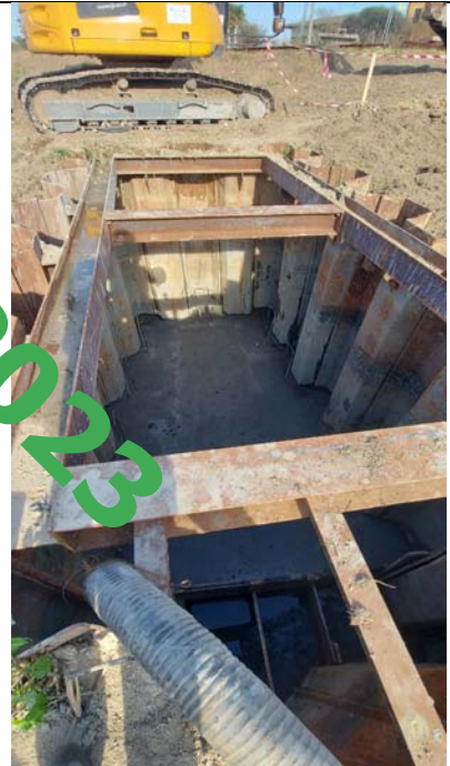
Idrovora Cantarana di Cona. Fase di realizzazione della nuova vasca di aspirazione. Struttura metallica portante e getto della platea.
