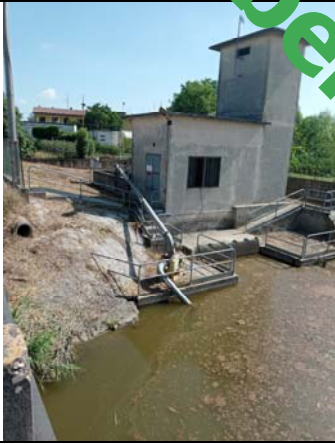
Sostegno Ponte Zata in Comune di Tribano. Posa di una pompa mobile per favorire l'alimentazione dello scolo Olmo durante la criticità idrica dovuta alla siccità.
