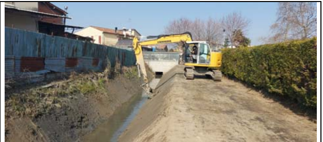
Scolo cons. Paltanella in Comune di Cartura. Presidio di sponda costituito da pali infissi al piede spondale e pietrame, copertura con terreno per favorire l'inerbimento.
